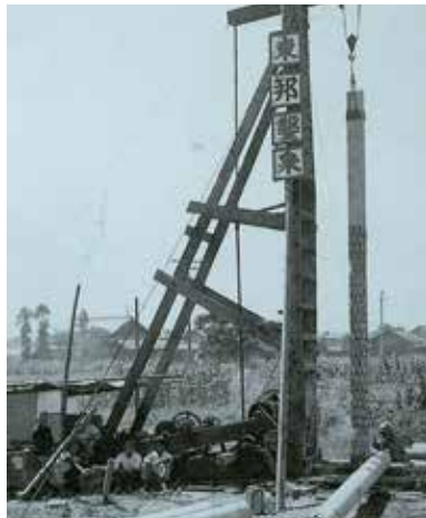
当時の深井戸工事
