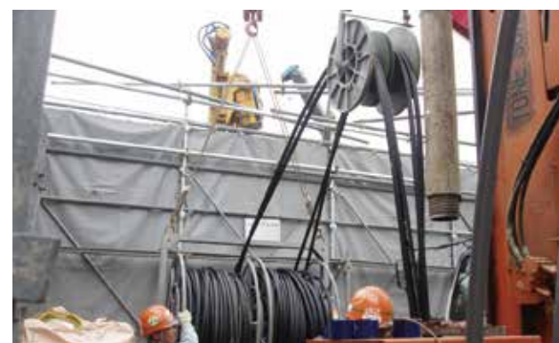
熱交換用パイプ設置
