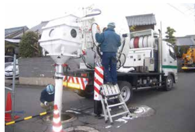
管渠更生工事施工風景
