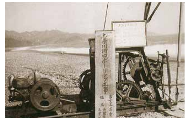
昭和28年当時の衝撃式ボーリング機
