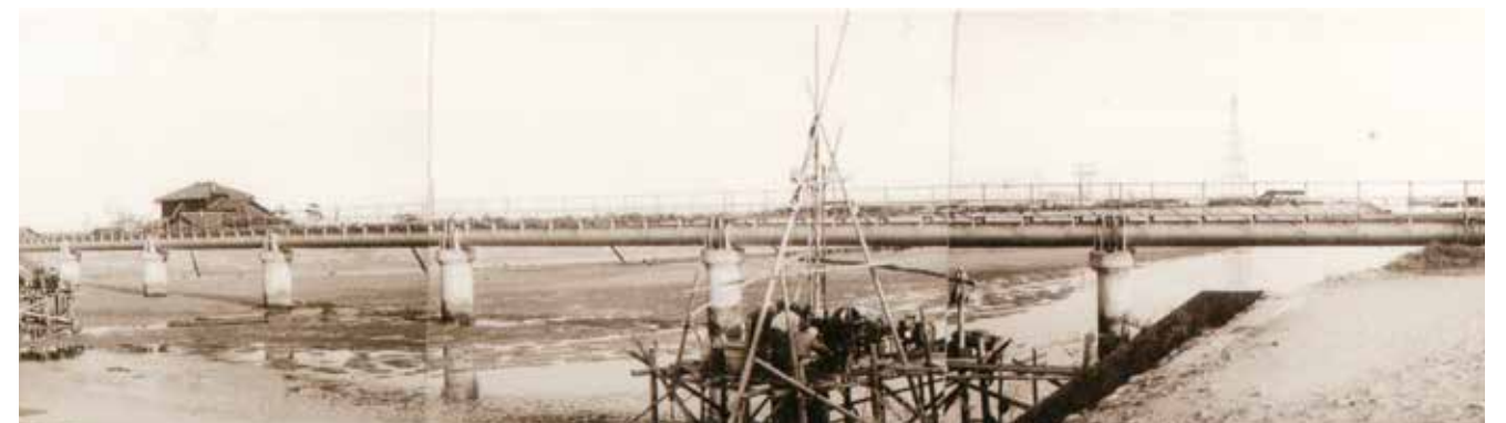
現名四国道（国道23号線）大正橋調査ボーリング
