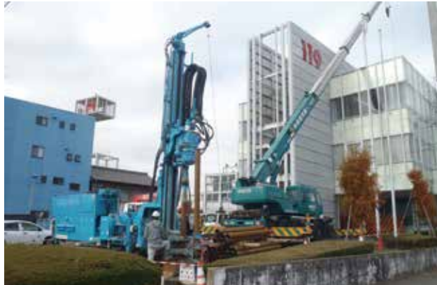
ソニックドリルによる掘削
