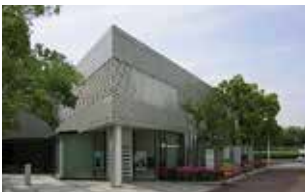
大阪府立国際児童文学館 （大阪府 吹田市） 冷暖房／熱交換井 60m×8 本 （地中熱源方式）
