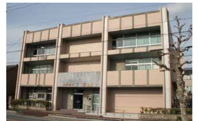
本社社屋（現在） ※平成18年の耐震改修工事より、多くの窓が壁構造となった
