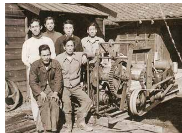
昭和28年当時の衝撃式ボーリング機
