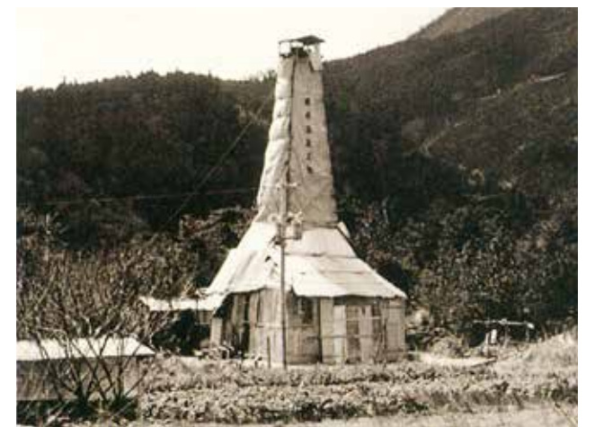
湯の山温泉調査ボーリング（昭和37年）
