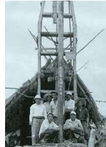
戦後の機械式掘削機
