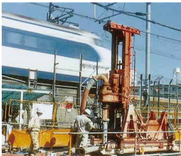
場所打杭工事
