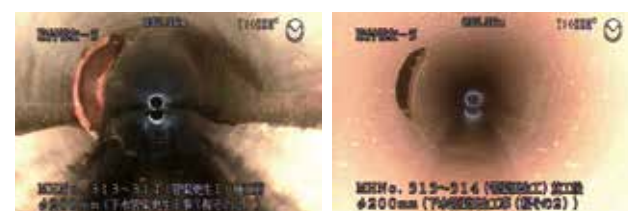
管渠更生工事施工前
