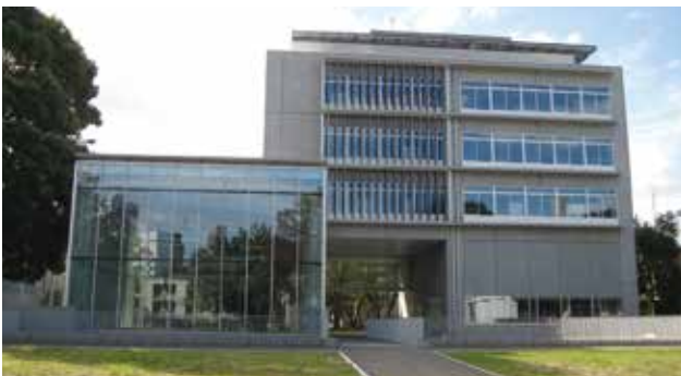
東京大学駒場キャンパス（東京都） 冷暖房／熱交換井 100m×10 本（地中熱源方式）
