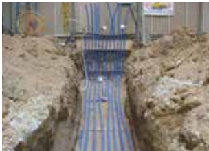
熱交換パイプ埋設状況
