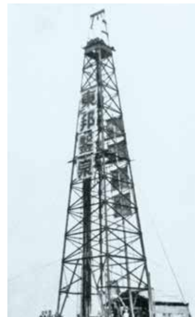
新湯の山温泉掘削風景
