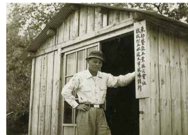
鵜殿村水道工事現場事務所
