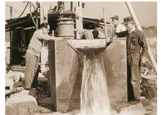
深井戸工事の揚水試験
