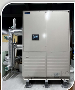
地中熱ヒートポンプ
